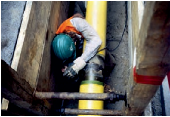
Bild A6.5: Rohrgraben mit Holzverbau: feuchtes Holz ist leitfähig.
