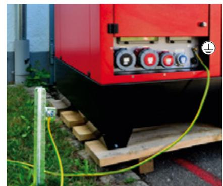
Abb. 15 Stromerzeuger mit Erdungsanschluss und Erdspieß
