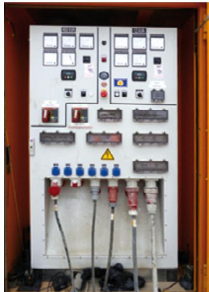
Abb. 14 Anschlussfeld eines Stromerzeugers mit integrierten RCDs
