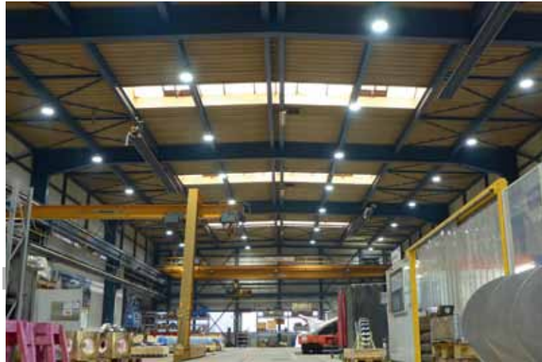
◀ Die Deltaluxx-Leuchten sorgen für ein passendes Licht und ausreichende Beleuchtungsstärke auch für exakte Arbeiten an den Werkstücken.
