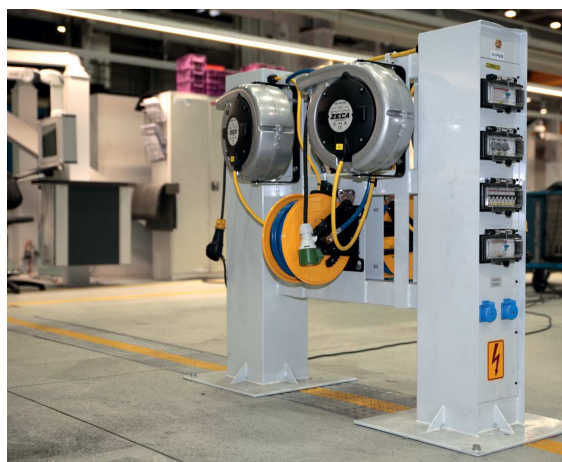
Insgesamt werden mit dem neuen Konzept jeweils vier Arbeitsplätze pro Säule bedient. Bild: Gifas Electric
