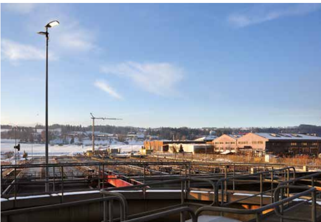
ARA „Energiepark“, Morgental
