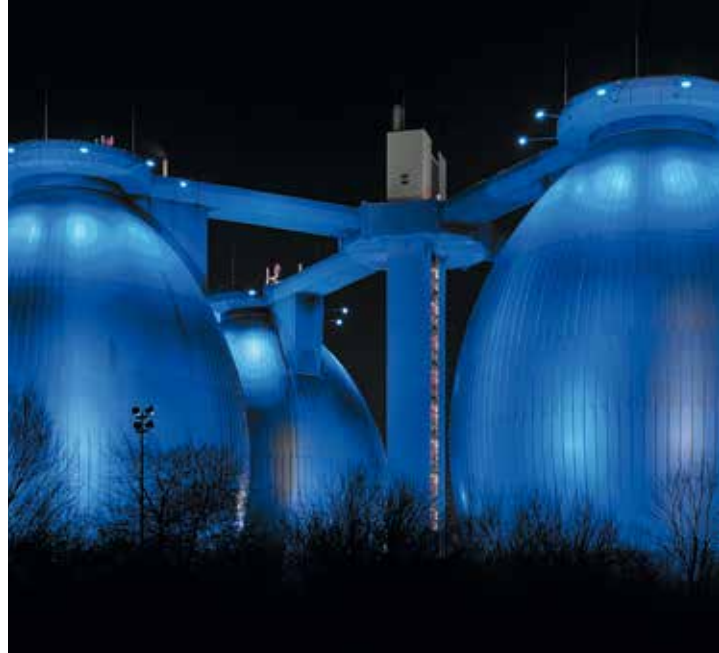
Abb.: Die Eierform der Faultürme erwies sich als optimal in Bezug auf Wirtschaftlichkeit, Prozessvorgang und Optik.
