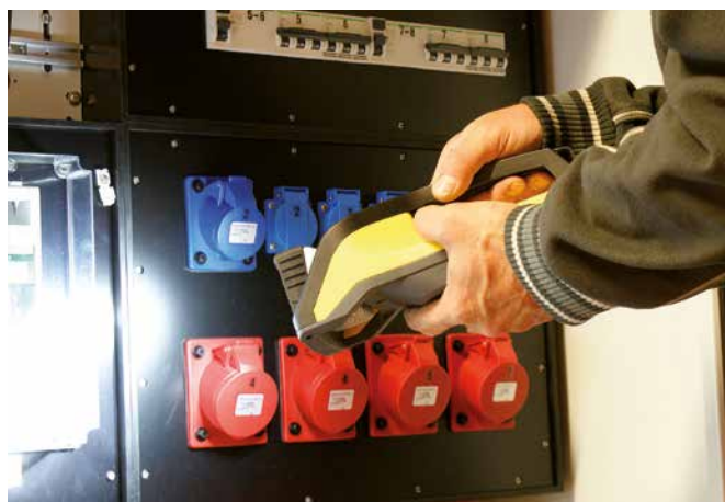
FlashLED - Einsatz bei Wartungsarbeiten
