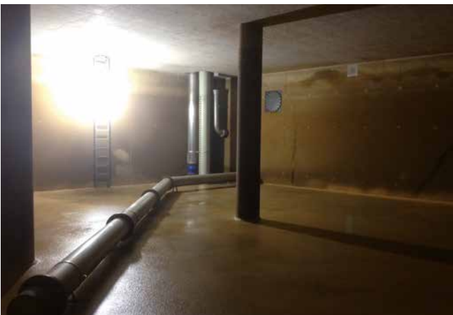
Einsatzort Stadtwerke, Entsäuerungsanlage
