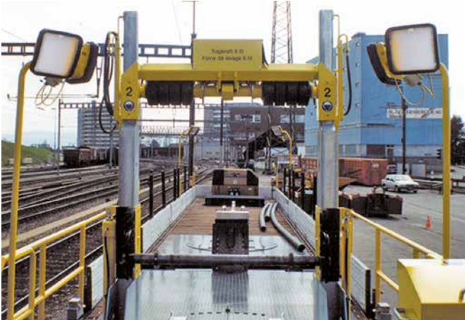
PrimaLED - Beleuchtung Wartungsanlage
