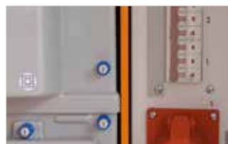
ISO-Gehäuseabdeckungen mit plumbierbaren Schnellverschlüssen für einfache Montage
