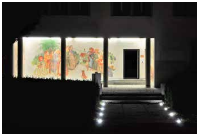
Öffentliches Gebäude, CircLED
