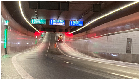
LED-Beleuchtung verbessert im Marieholmstunnel im schwedischen Göteborg die Erkennung des Straßenverlaufs
