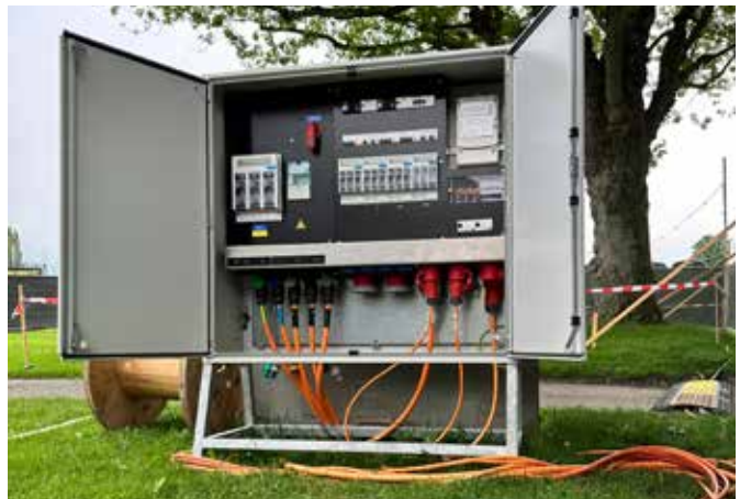
Baustromverteiler
