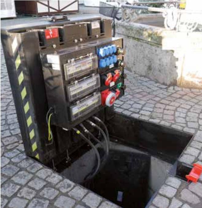
Massive Edelstahlkonstruktion (V2A/1.4301) 1000x1000mm, Gasdruckfedern zum vollautomatischen Öffnen, Schachtdeckel individuell befüllbar, Verteilerbestückung nach Kundenwunsch.
