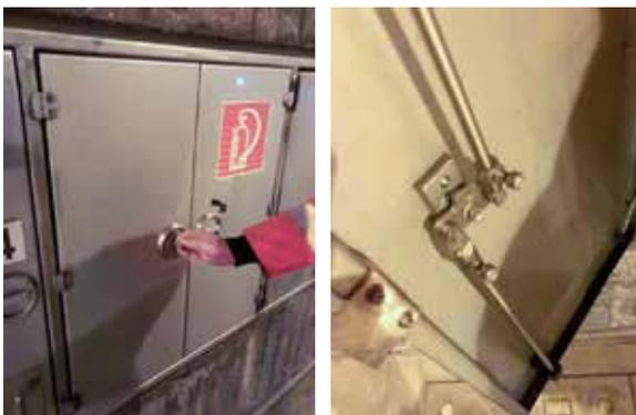
Die Öffnung und Schließung des Feuerlöscherverwahrungsschranks erfolgt über die außenliegenden Klappmuschelgriffe aus V4A 1.4571.
