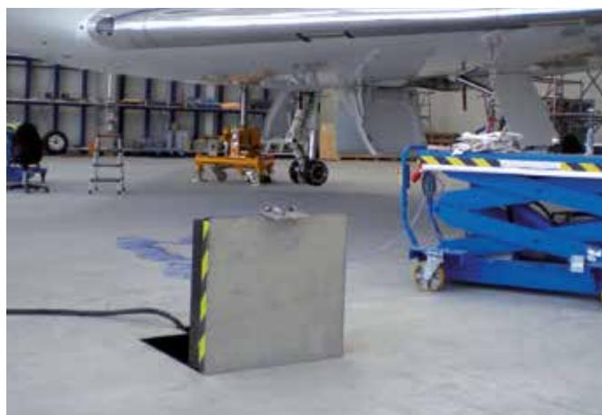
Der GIFAS-Unterflurverteiler PIAZZA 2000 ist speziell für die Anwendung auf Wartungsstützpunkten und im Hangar oder sonstige Schwerlastanwendungen ausgelegt.
