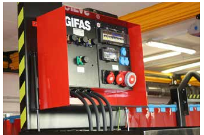
Unterflurverteiler
