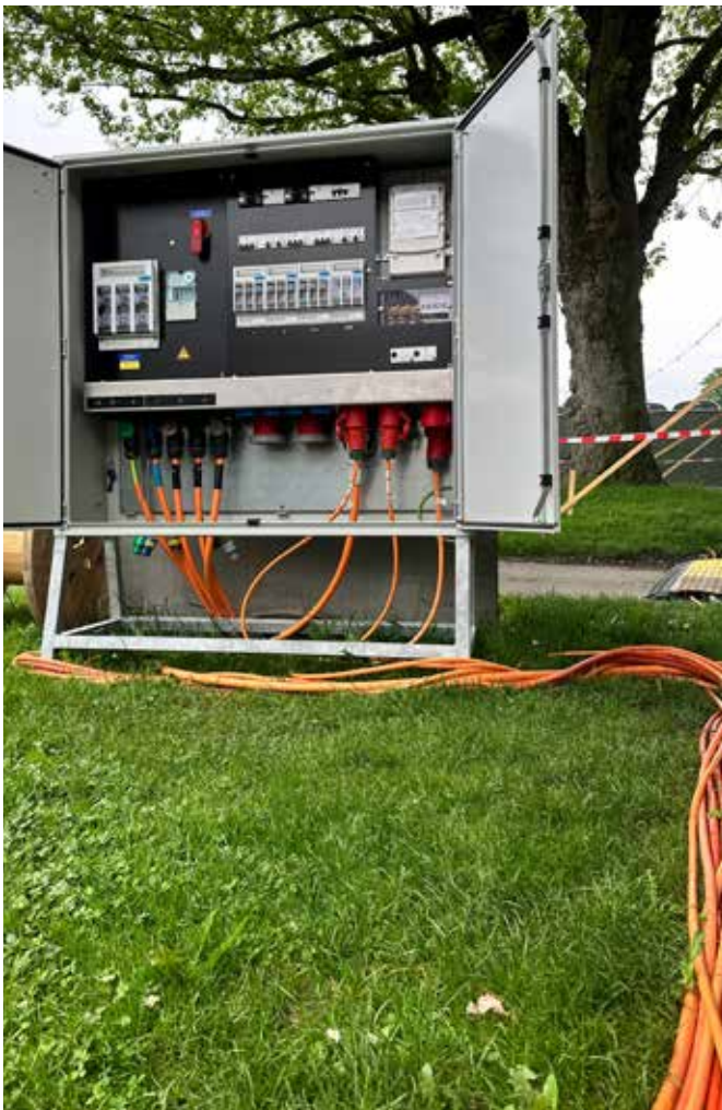
Baustromverteiler
