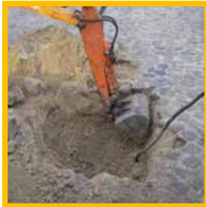
Ausheben der Baugrube
