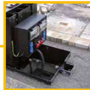
Umfüllen und Einbetonieren
