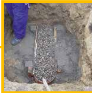
Auffüllen der Baugrube
