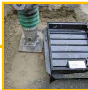
Umfüllen und Einbetonieren
