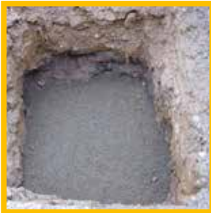
Ausheben der Baugrube
