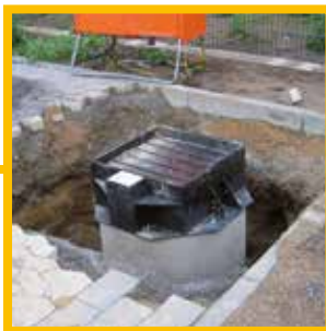
Einsatz der gesamten Einheit in die vorbereitete Baugrube
