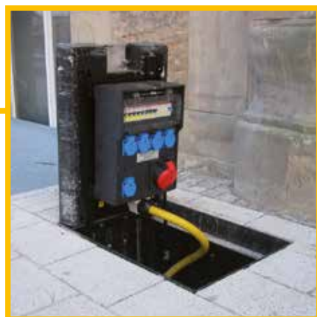
Fertig eingebauter CAMPETTO
