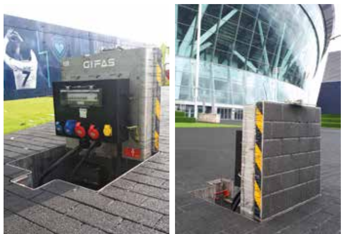
Tottenham Hotspur Station, PIAZZA 700 und PIAZZA 1000
