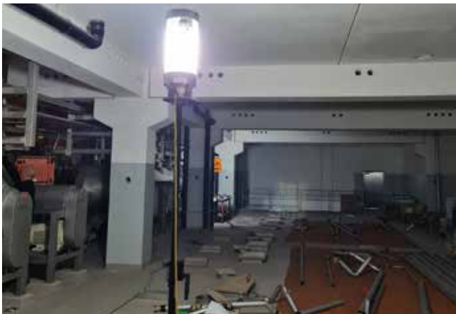
Beleuchtung für Trockenbauarbeiten
