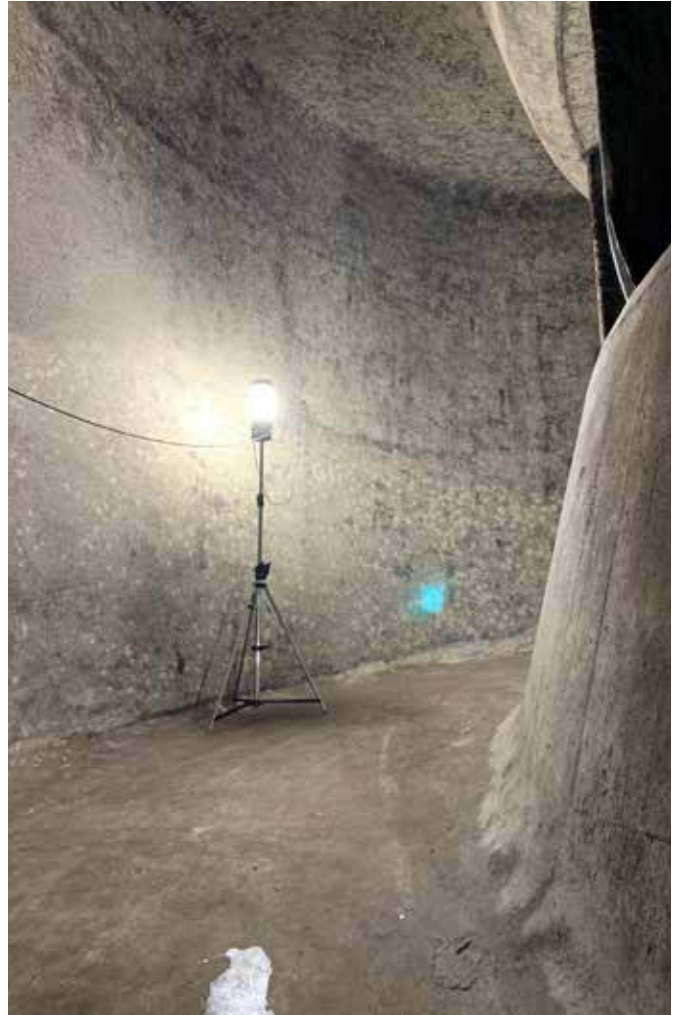
Beleuchtung für Revisionsarbeiten
