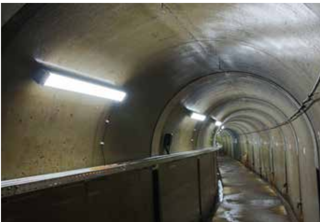
Revisionsschachtbeleuchtung
