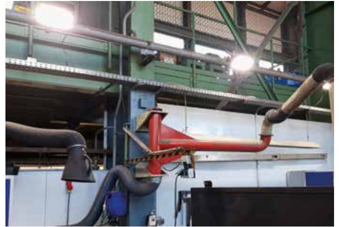
Beleuchtung Industriewerkstatt mit Schweißarbeitsplatz
