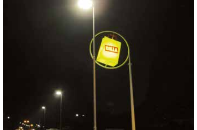
Parkplatzbeleuchtung Billa, Mistelbach
