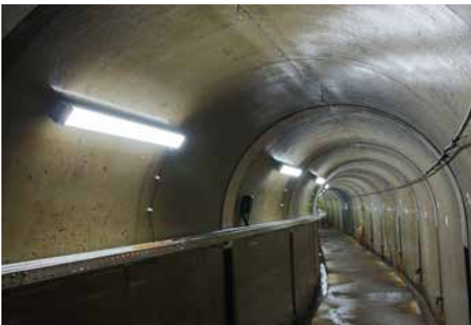
Revisionsschachtbeleuchtung
