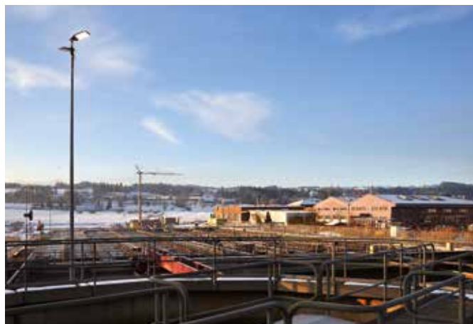
ARA „Energiepark“, Morgental
