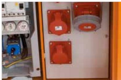
90° schwenkbares Abnehmerteil ist schräg gestellt – dadurch keine Verletzungsgefahr
