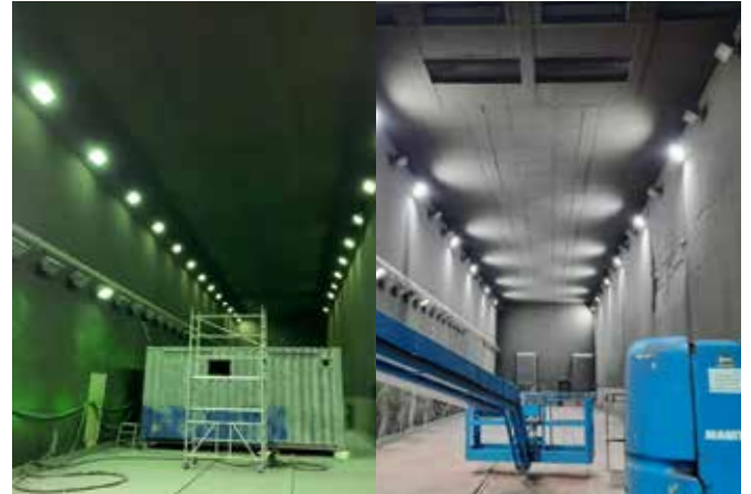
Beleuchtung Strahlhalle (vorher/nachher)
