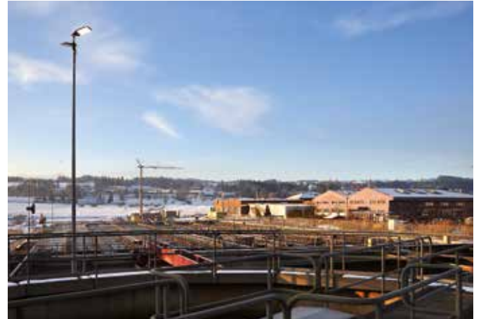
ARA „Energiepark“, Morgental
