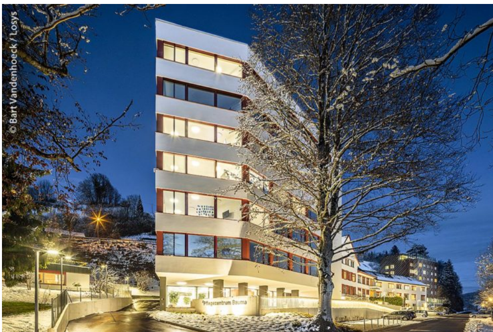
Das neu gebaute Pflegezentrum im schweizerischen Bauma wurde mit einer LED-Sicherheitsbeleuchtung ausgestattet.
