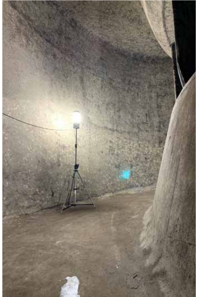
Beleuchtung für Revisionsarbeiten
