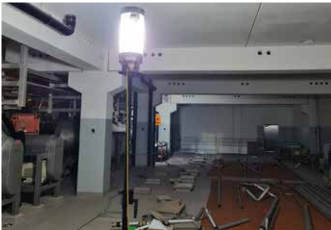
Beleuchtung für Trockenbauarbeiten
