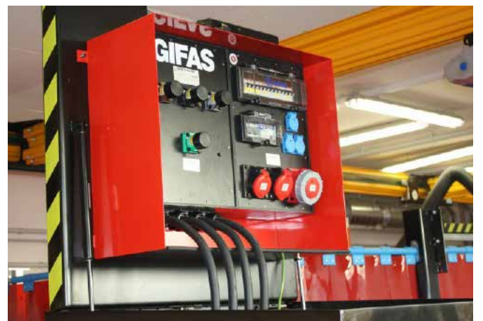
Unterflurverteiler
