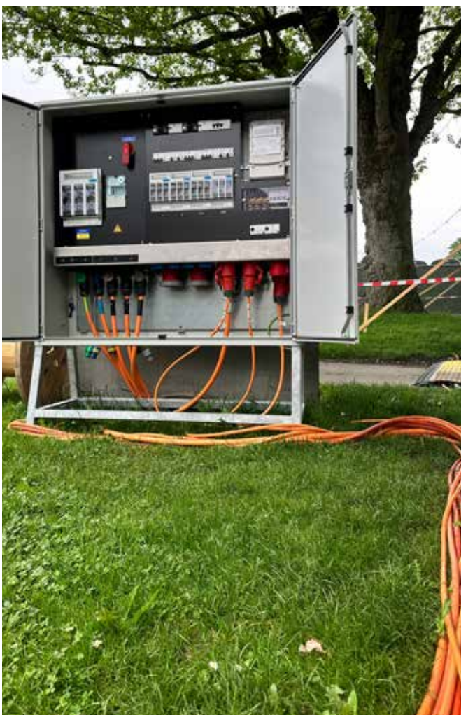
Baustromverteiler
