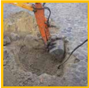
Ausheben der Baugrube
