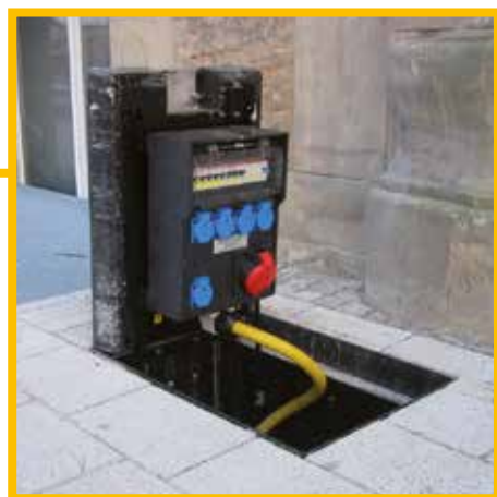
Fertig eingebauter CAMPETTO
