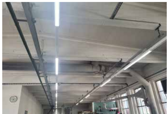
Beleuchtung mit modulares LED Schienensystem
